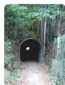
軍用トンネル (通行できます)
