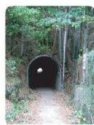
軍用トンネル (通行できます)
